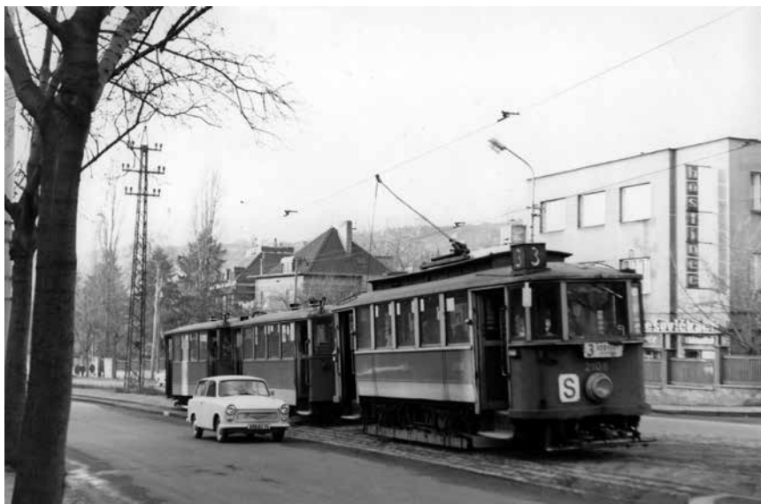
Ulici V Holešovičkách (poblíž zastávky Rokoska) dokumentuje tento snímek se soupravou tramvajů v čele s vozem ev. č. 2108 z 6. 12. 1970. Z fotografie je dobře patrné umístění stožáru vysokého napětí mezi kolejemi. Proto zde měla trať neobyčklou osovou vzdálenost kolejí 4,8 m. © J. Bureš 1970
