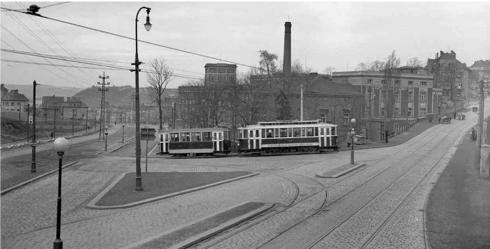
Další ze záběrů z roku 1936 ukazující původní řešení křižovatky Vychovatelna a tratě v ulici V Holešovičkách (se sloupy vysokého napětí uprostřed tratí). sbírka: archiv DPP
