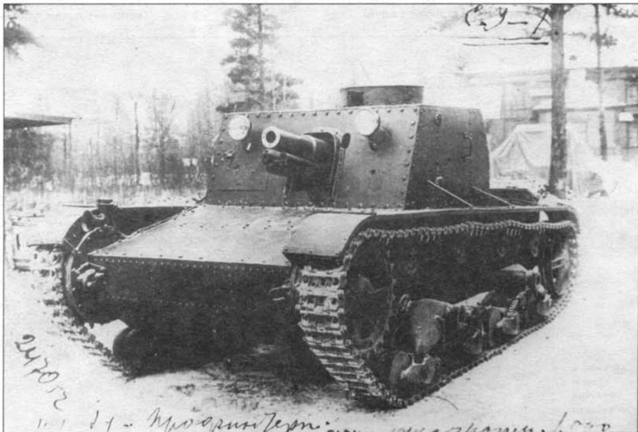
Самоходная установка СУ-1 перед испытаниями стрельбой. НИИП, ноябрь 1931 г.
