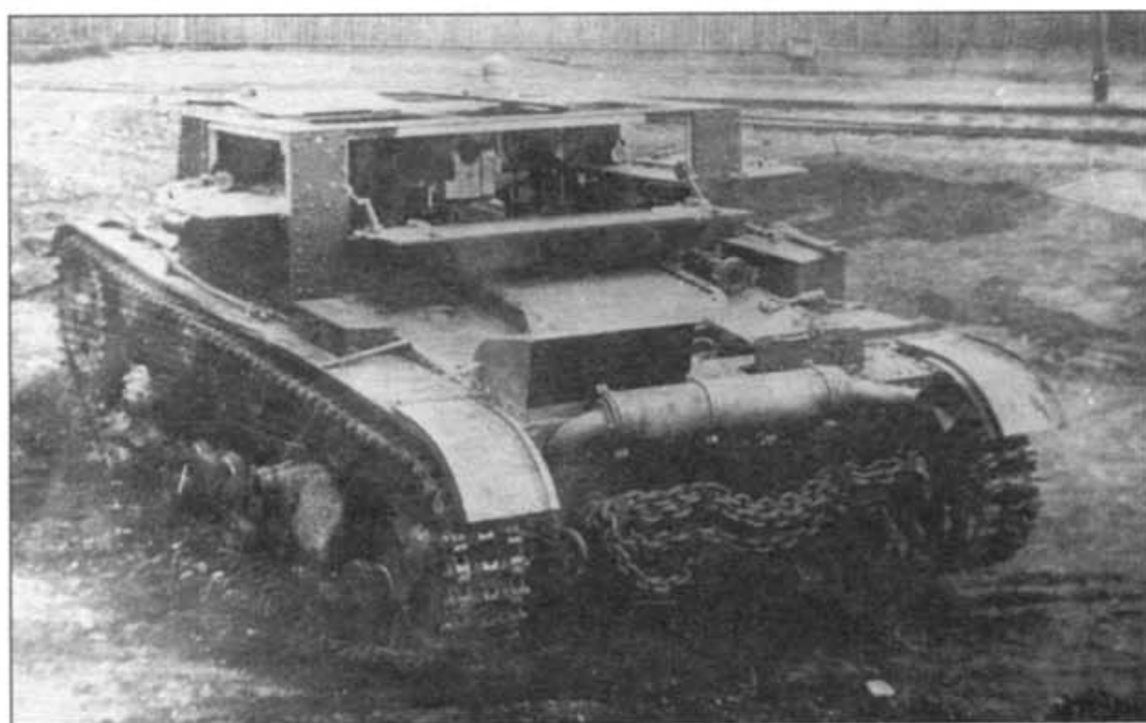
Самоходная установка АТ-1 во дворе завода № 185. На нижнем снимке — машина в боевом положении с откинутыми бортовыми и кормовым щитами рубки
