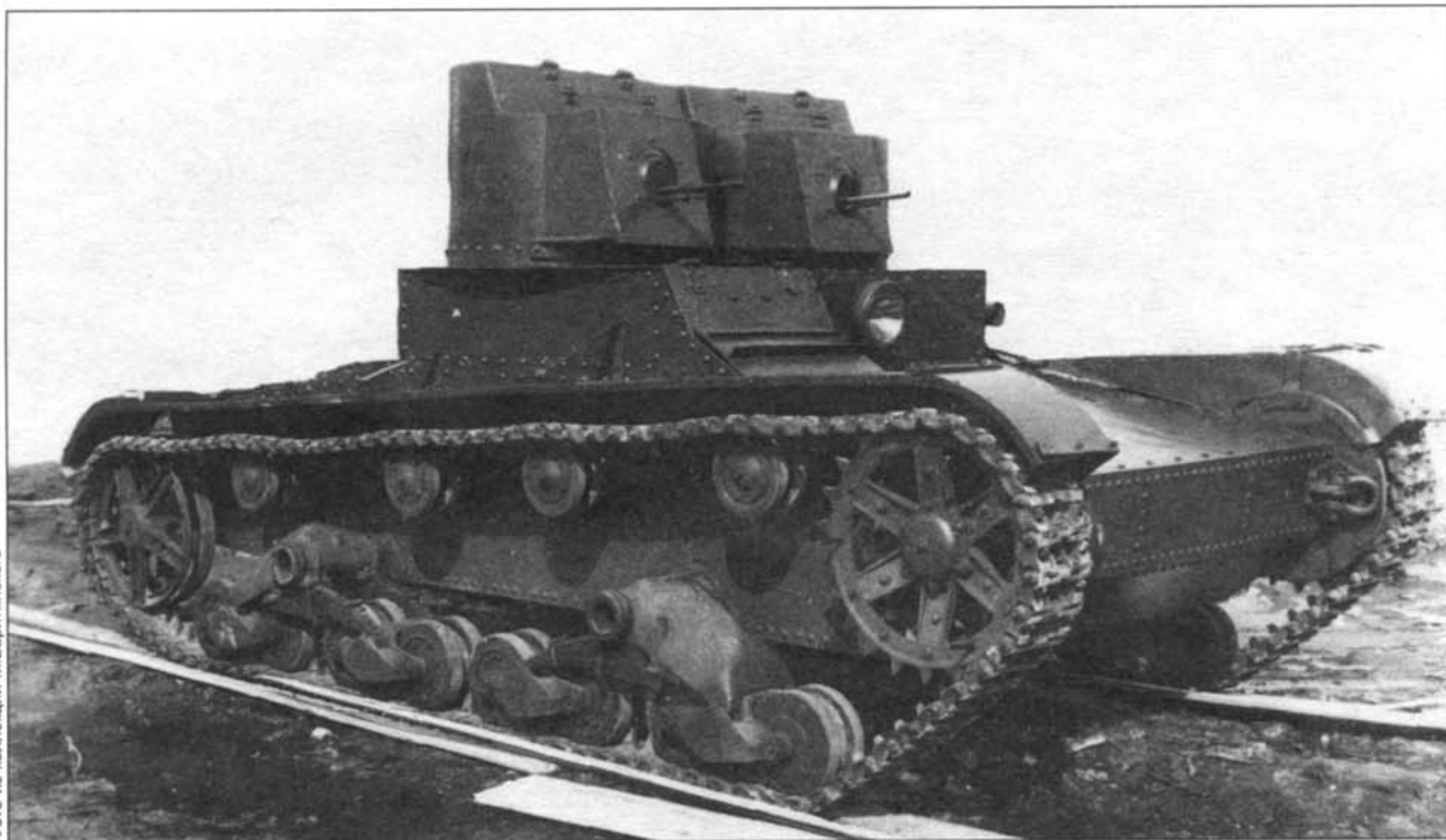
Танк Т-26 обр. 1931 г. со сварными башнями. В ходовой части используются опорные катки позднего выпуска со съемными бандажами. НИБТПолигон, 1940 г.
