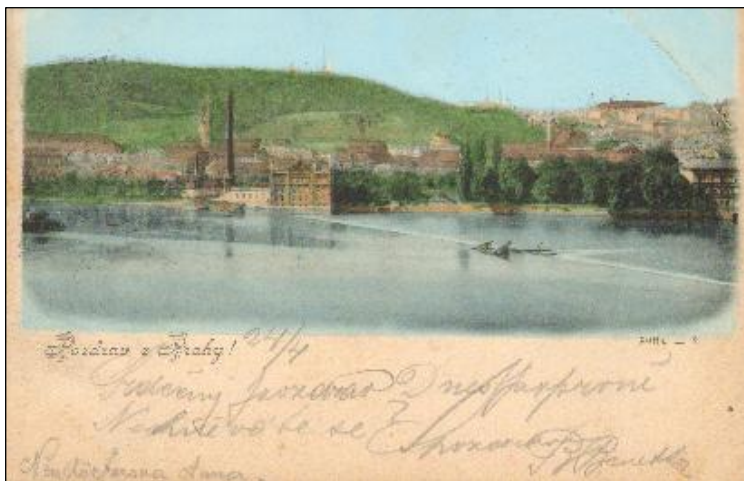
T5961 – Mlýn na Kampě po požáru v roce 1896, celkový pohled z roku 1899
